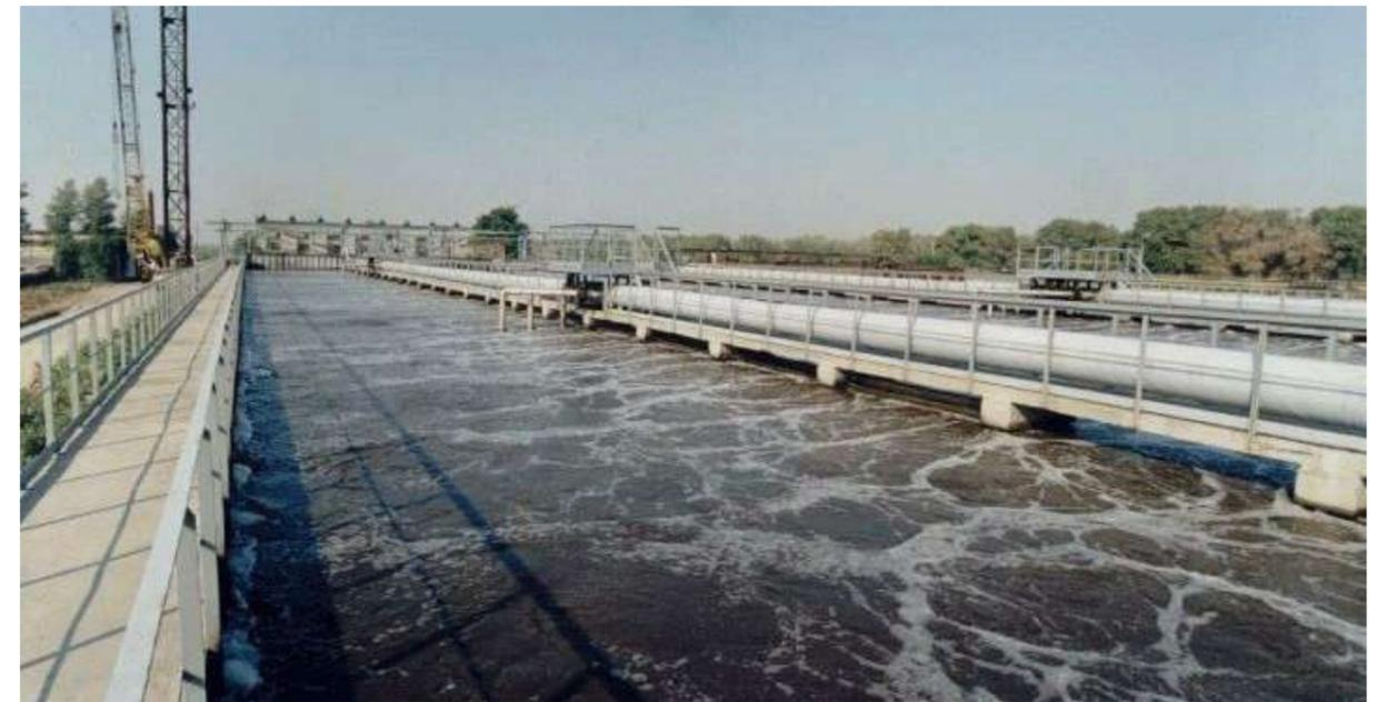
Фото 7. Аэротенки первой очереди очистных сооружений канализации города Ростова-на-Дону после реконструкции
